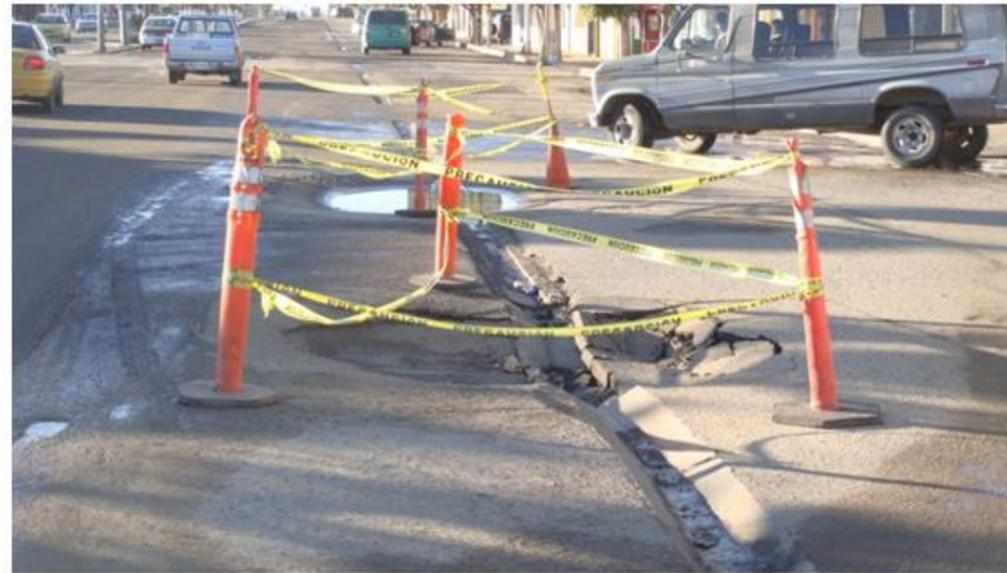
Figura I.2. Evidencia del hundimiento en el boulevard Benito Juárez.
